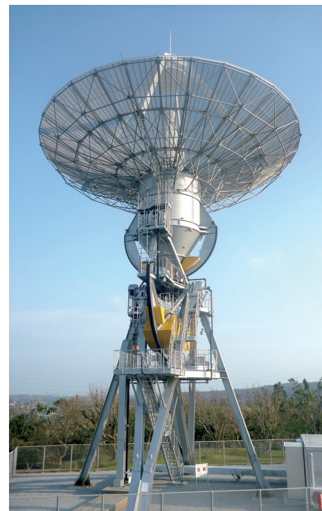
沖縄第2可搬局用パラボラアンテナ
